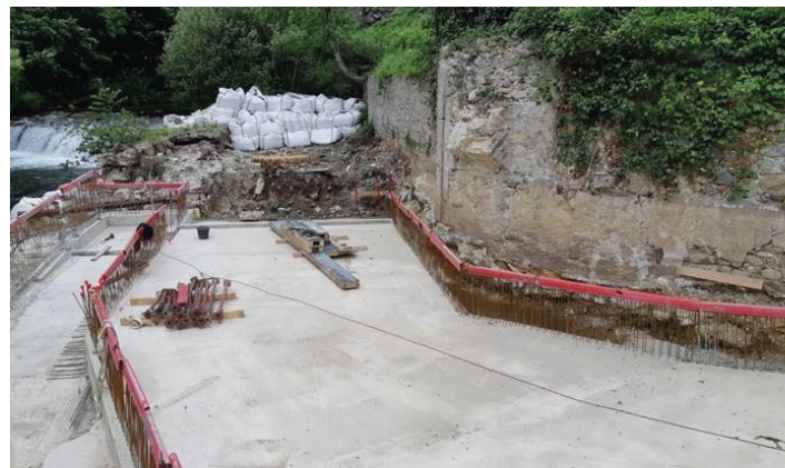
Ferrailage et coulage du radier de la prise d'eau
